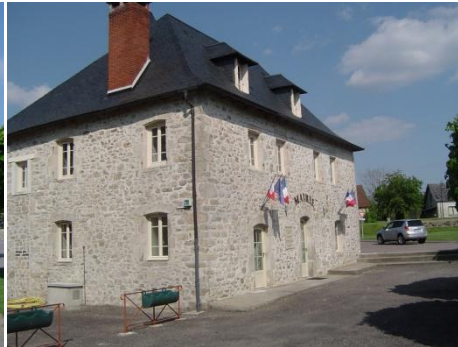
Nouvelle façade Mairie (de coin)
