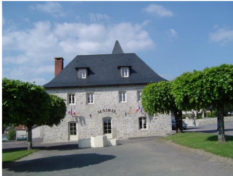
Nouvelle façade Mairie (de face)
